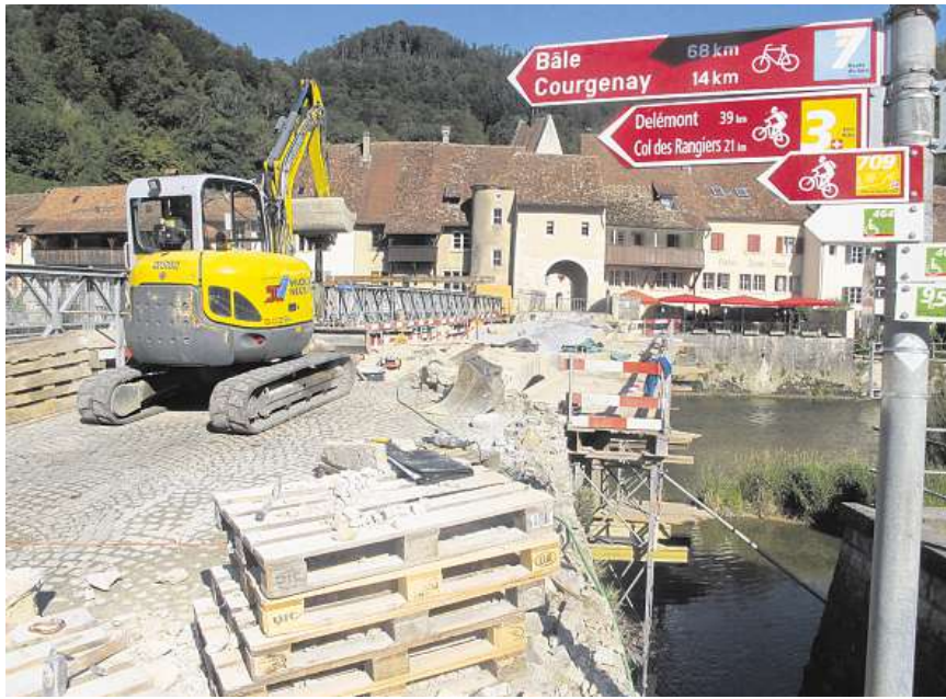
Sanierung in Etappen. Der Übergang St-Jean aus dem Jahr 1728. Foto Christian Fink
